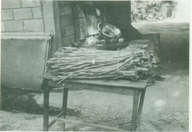
เปลือกสาแห้งใช้ทำกระดาดได้เช่นเดียวกับเปลือกข่อย
