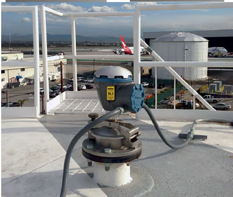
รูปที่ 6 เครื่องวัดระดับของเหลวภายในถังสำหรับชนิด Radar Gauging รูปบนเป็นเครื่องวัดที่ได้รับการพัฒนาในระยะแรกเริ่ม รูปล่างเครื่องวัดเริ่มเข้าสู่ยุคหลัง
