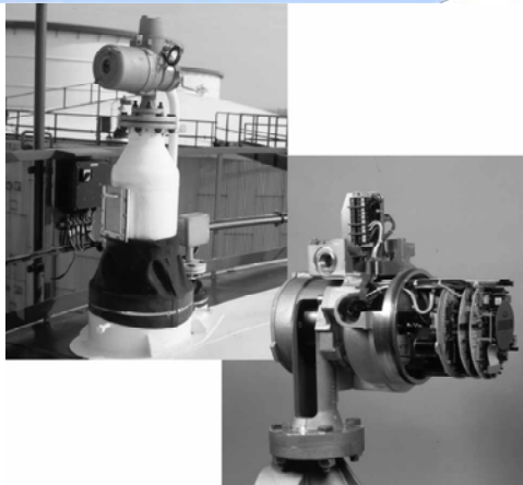
รูปที่ 4 เครื่องวัดระดับของเหลวภายในถังสำรองฯแบบ Servo Operated Displacer Level Gauge
