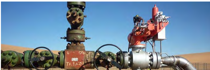
รูปที่ 6-19 แสดงการติดตั้งในภาคสนามของ Hydraulic Actuator
