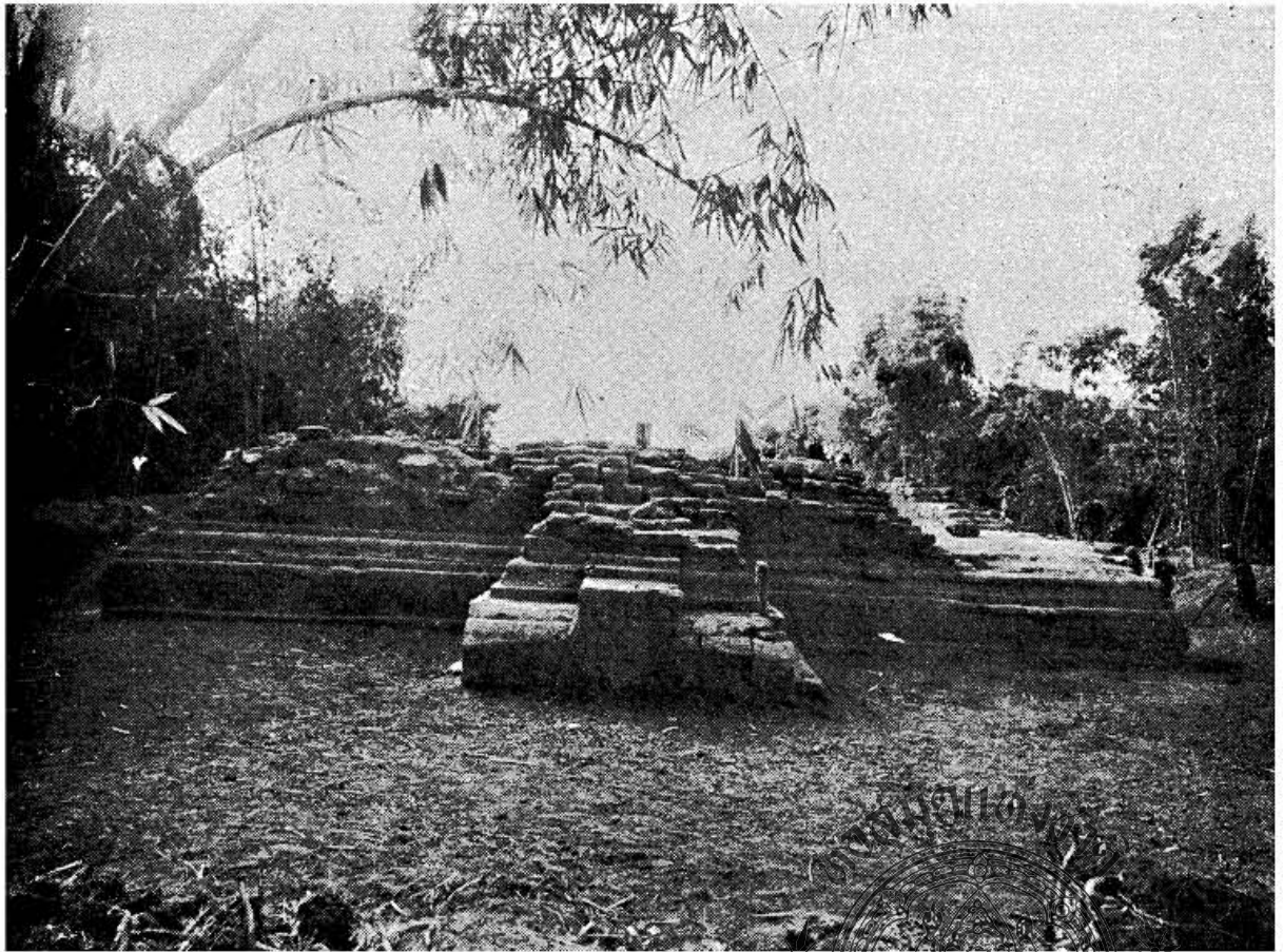
รูปที่ ๕๔ เทวสถานที่บ้านโคกขวาง หลังขุดแต่งแล้ว
