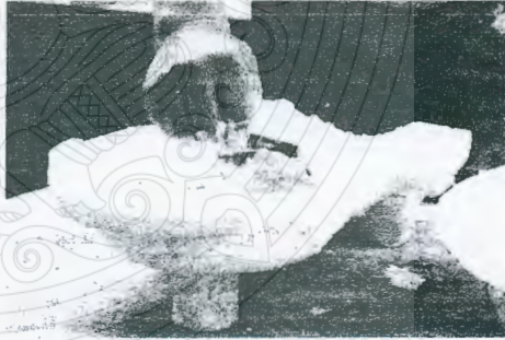
นำเหล็กปากปูนแต่งขอบให้เรียบเสมอกันทั้งชั้นหน้าและหลัง
