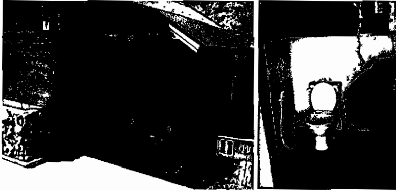
ห้องสุขา ปรับประตูให้เปิดออก เพื่อให้รถเข็นกลับตัวได้ และย้ายป้ายออกมาด้านหน้า
