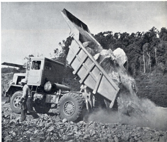
รถบรรทุกหินขนาดใหญ่จะ ปฏิบัติงานถมหินทางด้านนอกของ ตัวเขื่อนเพื่อป้องกันกระแส
