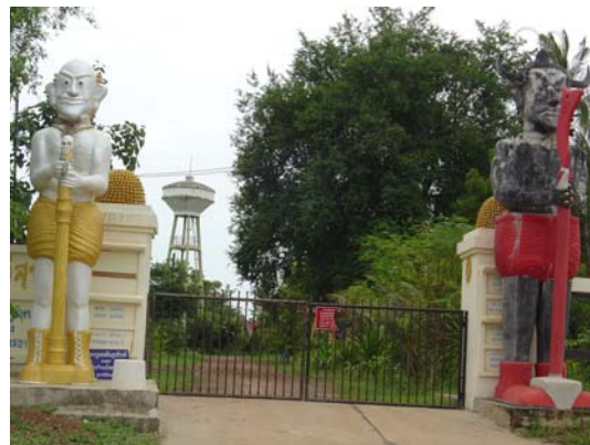
รูปที่ 4.28 สถานีน้ำประปาหมู่บ้านตั้งอยู่ภายในวัดบ้านธาตุโพทอง
