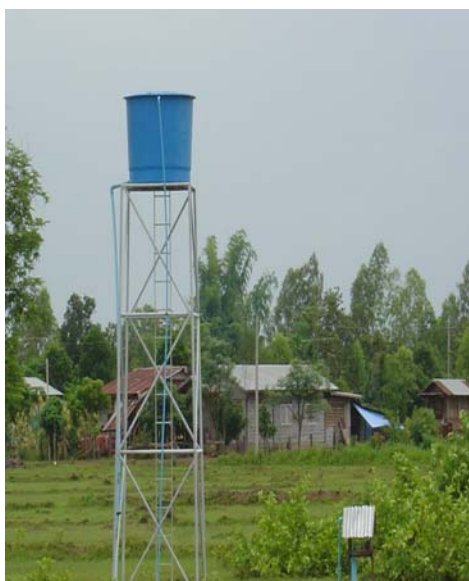
รูปที่ 4.34 บ่อน้ำบาดาลตั้งอยู่กลางทุ่งนาบ้านหนองตะไก้
