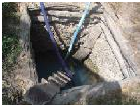
รูปที่ 4.37 บ่อน้ำภายในบ้านชาวบ้านอยู่ติดกับโรงแต่งแร่ มีน้ำตลอดปีเมื่อถึงฤดูแล้งที่น้ำบ่ออื่นแห้ง ชาวบ้านก็จะมาซื้อน้ำที่บ่อนี้ไปใช้
