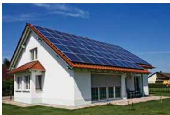
รูปที่ 5.14 ตัวอย่างการติดตั้งเครื่องทำน้ำร้อนพลังงานแสงอาทิตย์
