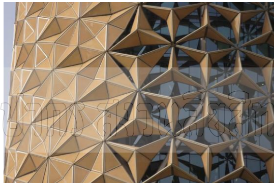
รูปที่ 6-35 แผงบังแดดอะลูมิเนียมปรับมุมบังแดดได้ตามตำแหน่งดวงอาทิตย์ ที่อาคาร Esplanade ประเทศสิงคโปร์ (ที่มา: https://livingnomads.com/2018/ )
