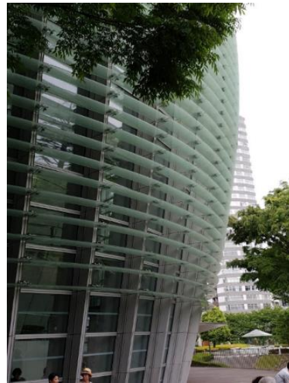
รูปที่ 10-23 การลดความร้อนและแสงจ้าโดยใช้แผงบังแดดทำด้วยกระจก Frit ที่ National Art Center Tokyo (NACT) ประเทศญี่ปุ่น
