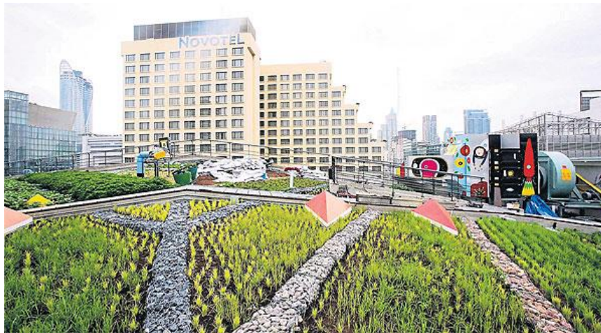
รูปที่ 11-5 การทำ Roof Garden ช่วยลดเกาะความร้อนในเมือง ช่วยลดน้ำฝนที่ไหลออกนอกพื้นที่ ลดความร้อนเข้าสู่อาคาร ทำให้คนได้ใกล้ชิดธรรมชาติ และยังสามารถเป็นแหล่งอาหาร ช่วยด้านเศรษฐกิจได้ด้วย (ที่มา: https://cutt.ly/boVDpRy )
