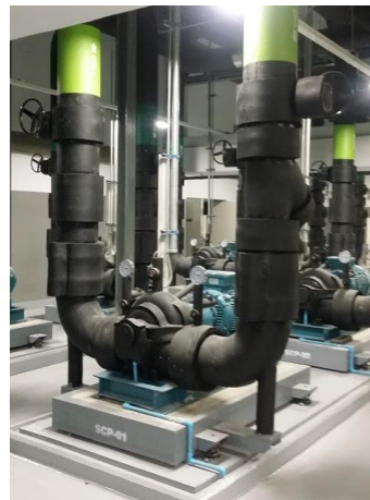
รูปที่ 9-8 Secondary Chilled Water Pump
