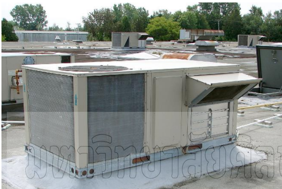
รูปที่ 9-3 Package Rooftop Unit
