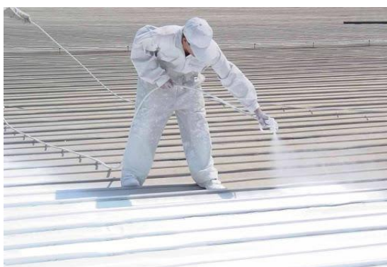
รูปที่ 8-46 การพ่นบนหลังคาด้วย Ceramic Coating
