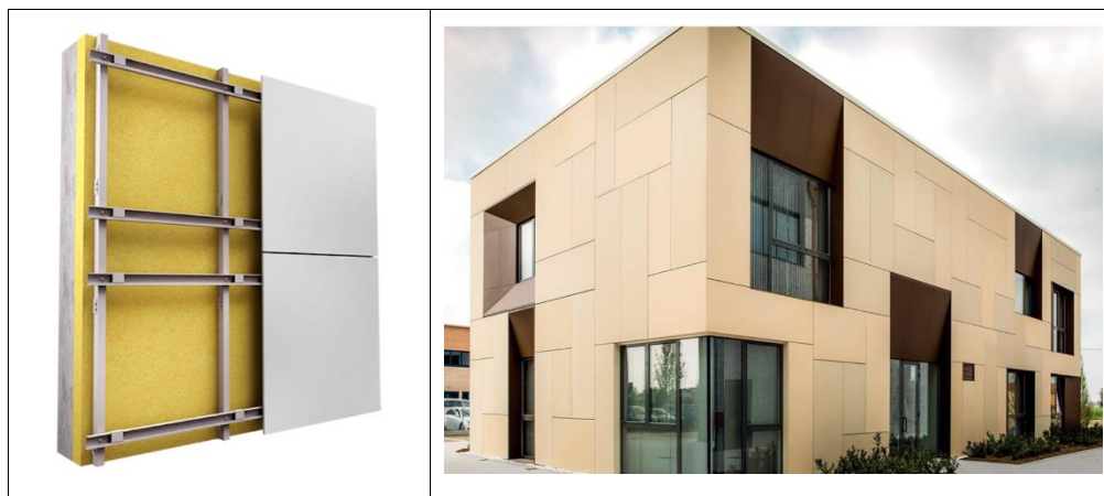
รูปที่ 8-44 แผง EIT ที่มีฉนวนภายนอกผนังหลักผิวเป็นโลหะ
