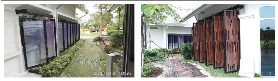
รูปที่ 11-12 การนำวัสดุใช้แล้ว (กระจกบานเกล็ด และไม้) มาดัดแปลงทำแผงบังแดดปรับมุม ที่อาคารห้องสมุด HSBC ที่ได้ LEED PLatinum v.3 (2009)
