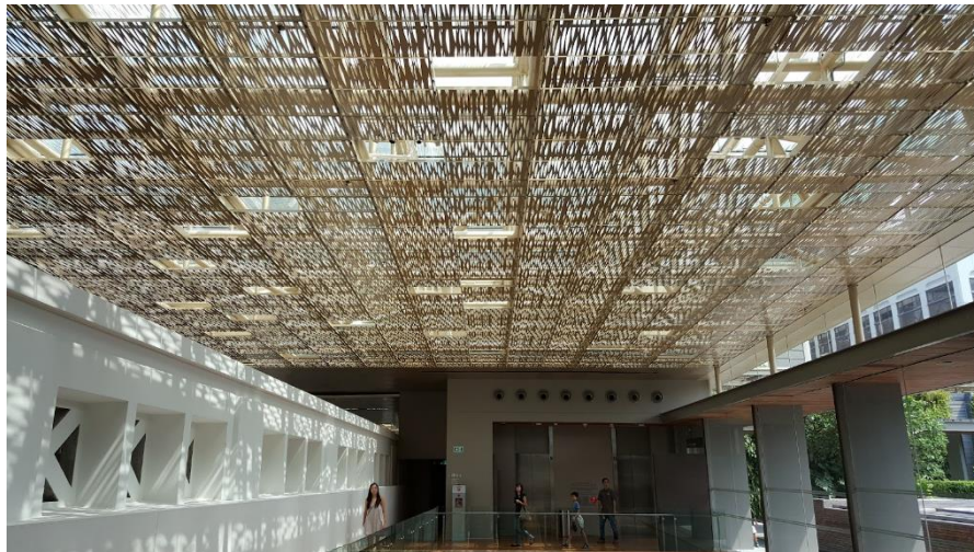
รูปที่ 10-34 การให้แสงจากหลังคาโปร่งแสงขนาดใหญ่ ซึ่งออกแบบเพื่อลดแสงจ้าและความร้อน โดยใช้โลหะฉลุลาย ที่ National Gallery of Singapore
