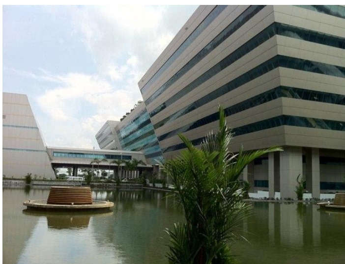
รูปที่ 8-43 ตัวอย่างอาคารที่ใช้ผนังระบบ EIFS - ศูนย์ราชการแจ้งวัฒนะ
