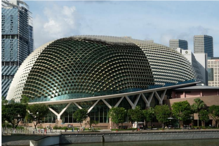
รูปที่ 6-35 แผงบังแดดอะลูมิเนียมปรับมุมบังแดดได้ตามตำแหน่งดวงอาทิตย์ ที่อาคาร Esplanade ประเทศสิงคโปร์ (ที่มา: https://livingnomads.com/2018/ )
