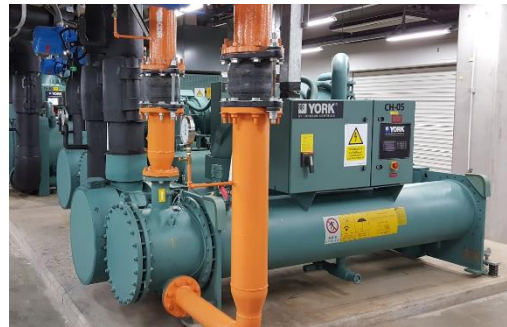
รูปที่ 9-6 เครื่องทำน้ำเย็นชนิดระบายความร้อนด้วยน้ำ
