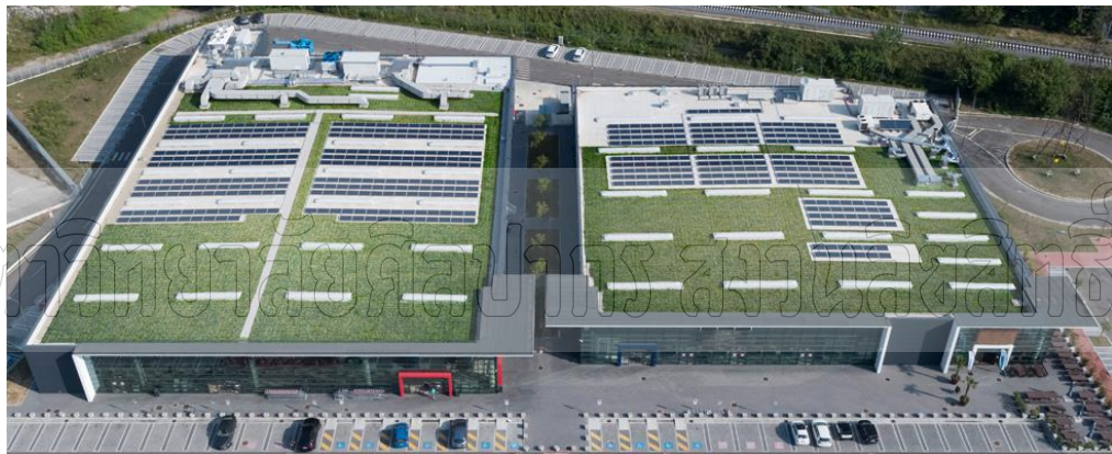
รูปที่ 8-52 อาคารซูเปอร์มาร์เก็ตในประเทศอิตาลี ใช้ Extensive Green Roof น้ำหนักประมาณ 60 กก./ตร.ม.
