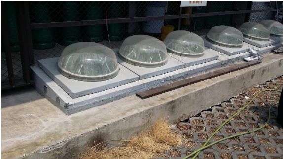
รูปที่ 10-37 หัวท่อนำแสงส่วนที่อยู่นอก อาคาร สสส.
