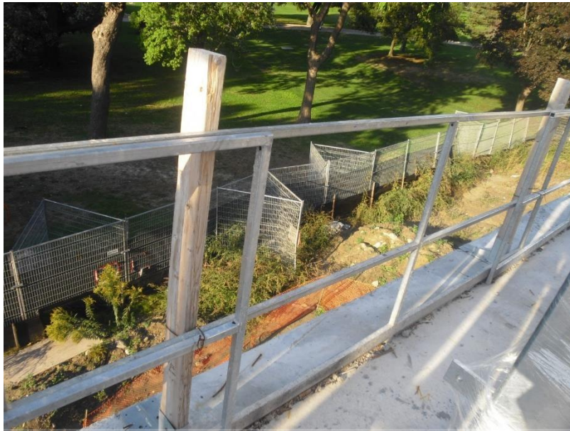
รูปที่ 11-2 การทำรั้วป้องกันตะกอนดินและเศษวัสดุต่าง ๆ เข้าไปยังที่ดินข้างเคียง ในโครงการที่ใช้มาตรฐาน LEED (ที่มา: ผู้เขียน)
