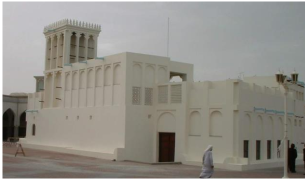
รูปที่ 6-38 บ้านพักอาศัยในอดีตในประเทศกาตาร์ ที่มีช่องเปิดในระดับที่ลมผ่านตัวน้อยมาก
