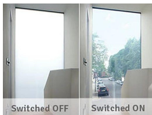
รูปที่ 8-39 กระจกสามารถปรับเป็นกระจกฝ้าเมื่อแดดมากระทบ
