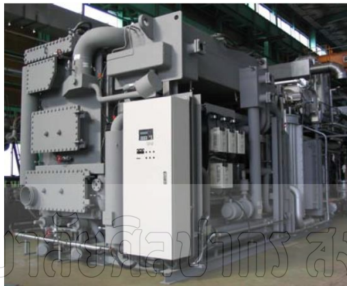
รูปที่ 9-16 Absorption Chiller แบบ Triple Effect (ที่มา: https://cutt.ly/7yXPIZG .)
