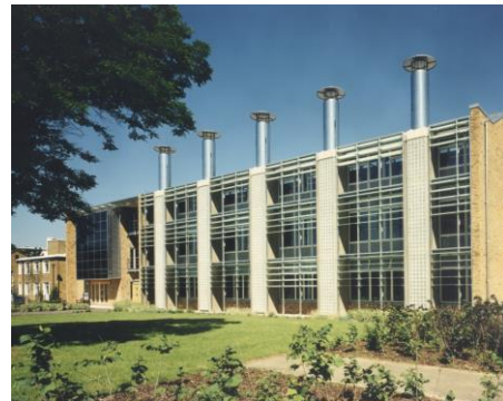
รูปที่ 6-54 การใช้ Solar Chimney ที่ Environmental Building Research Establishment (BRE) ของประเทศอังกฤษ
