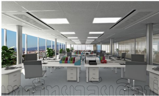
รูปที่ 9-38 การใช้ Active Chilled Beam
