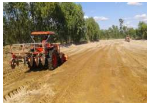
ภาพที่ 4.5 การสร้างค้นดินฐานกว้างและค้นดินฐานแคบในพื้นที่โครงการ
