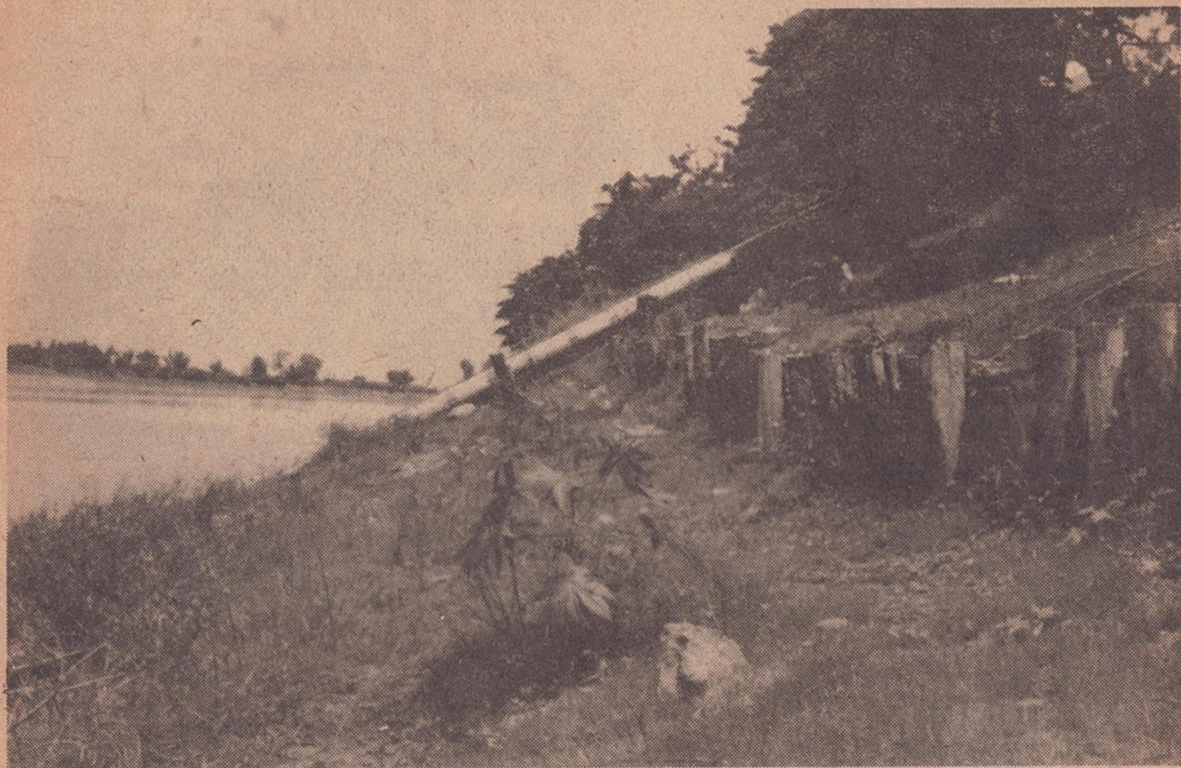
ท่อสูบน้ำซึ่งสูบน้ำจากแม่น้ำโขง
