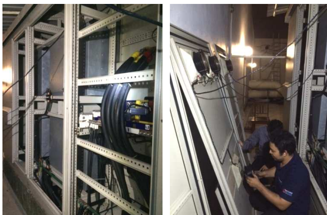
การดูแล บำรุงรักษา และปรับปรุง ซ่อมแซม แก๊วระบบต่าง ๆ ภายในอาคารต่าง ๆ ของหอสมุดแห่งชาติ
