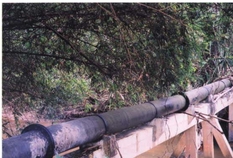
รูป 7 : ท่อส่งน้ำคลองประปาขุนพิง
