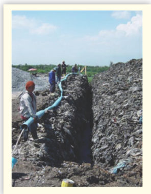
รูปแสดงการวางท่อรวมก๊าซชีวภาพและระบบฝังกลบเพื่อผลิตก๊าซชีวภาพ
