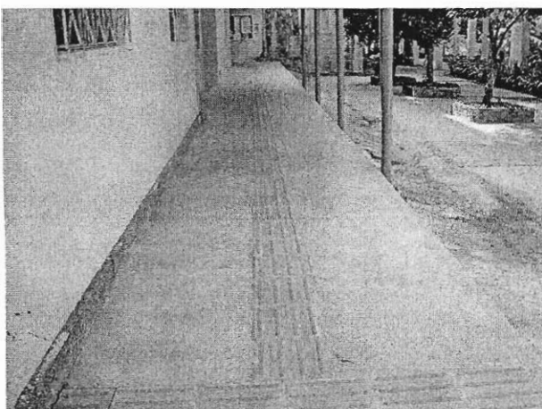
ภาพทางลาดจุดที่ 6 ที่ดำเนินการปรับปรุงแล้ว ปรับปรุงด้วยการเทปูนถมพื้นให้เสมอเป็นระนาบเดียวกันทั้งหมด
