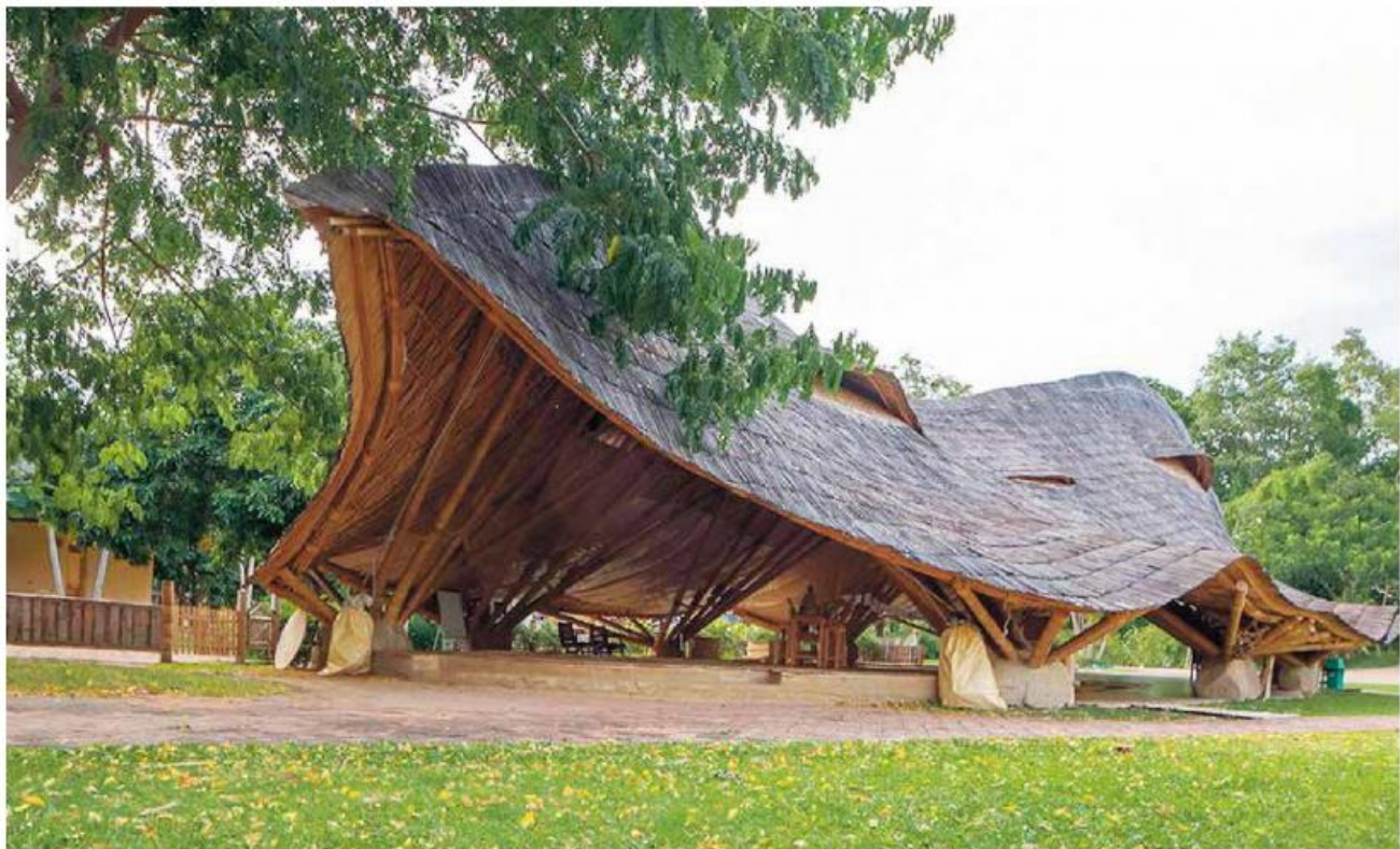
โรงเรียนเด่นปัญญา จังหวัดเชียงใหม่ การสร้างสรรค์สถาปัตยกรรมจากโครงสร้างไม้ไม่ได้ด้วยเทคนิคจักสาน
