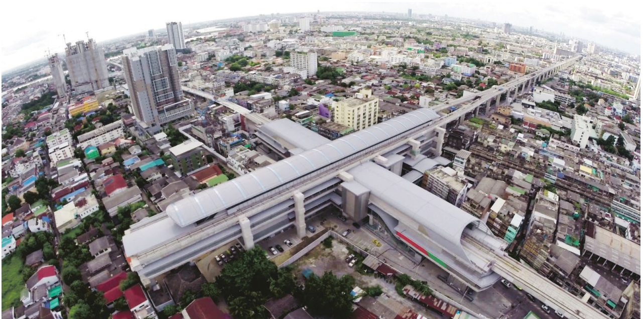
สัญญาที่ 5 สถานีเตาปูน สถานีเชื่อมต่อโครงการรถไฟฟ้ามหานคร สายเฉลิมรัชมงคล และโครงการรถไฟฟ้ามหานคร สายฉลองรัชธรรม
