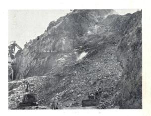
🛦 ภาพแสดงการเจาะ – ระเบิดที่ตั้งตัวเขื่อนฝั่งขวา Boring and explosion to make way for the dam site.
