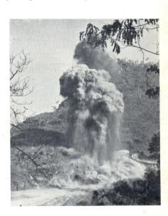
🛦 ภาพการระเบิดขยายปากอุโมงค์ผ้นน้ำ Explosion to enlarge the tunnel diverting the watercourse.
