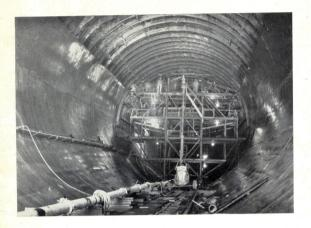
ภาพภายในอุโมงล์ แสดงการเทคอนกรีต Concrete pouring inside the tunnel.
