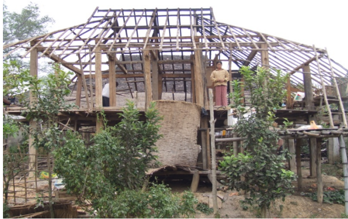
การขึ้นโครงสร้างตัวเรือนของชาวไทเขิน
