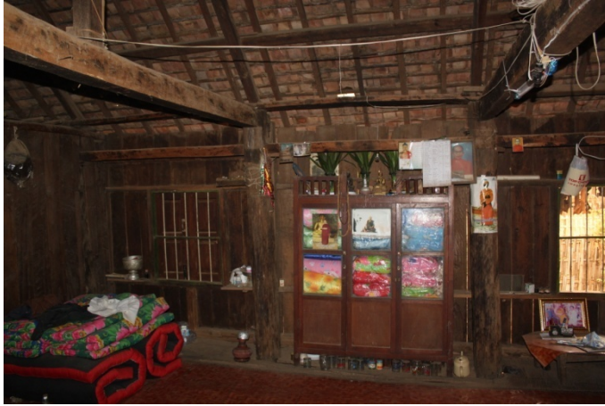
เสาพญาด้านซ้ายของภาพ เสานางด้านขวาของภาพและเพ่งพะลาจะอยู่ตรงกลาง
