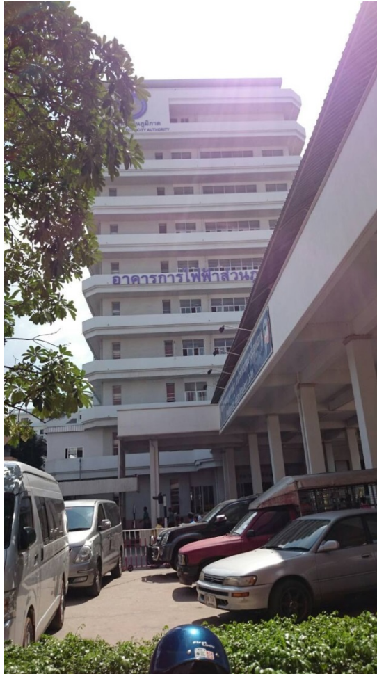
รูปที่ 4.2 อาคารการไฟฟ้าส่วนภูมิภาค โรงพยาบาลมหาราชนครราชสีมา
