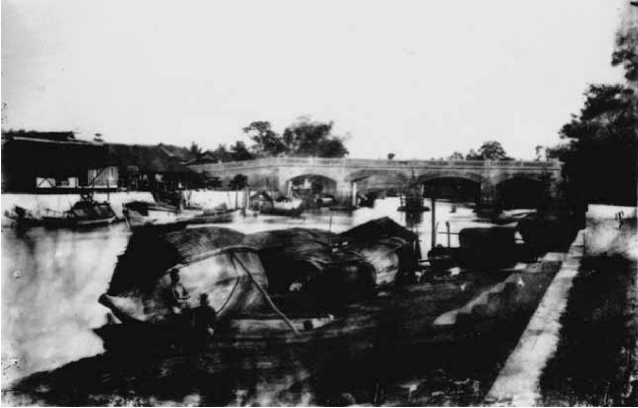
สะพานช้าง (ปัจจุบันคือสะพานพระจอมเกล้า) จังหวัดเพชรบุรี (ภาพถ่ายสมัยรัชกาลที่ ๕)
