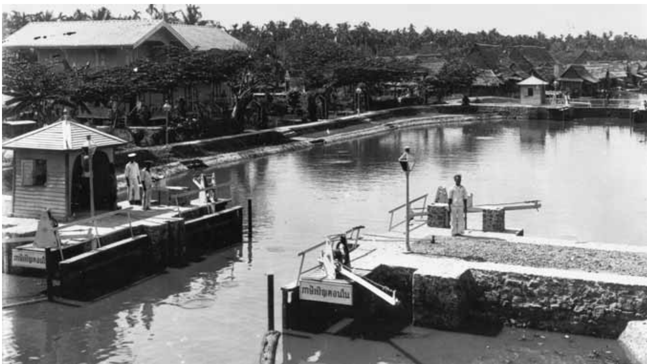
คลองภาษีเจริญ พระภานุสมบัติปริบูรณ์ (ยิ้ม พิศลยบุตร) ได้กราบบังคมทูลขอพระราชทานพระบรมราชานุญาตขุดเมื่อ พ.ศ. ๒๔๐๙ ระยะทางจากบ้านดอนไก่อติ (ดอนกะฎี) แขวงเมืองสมุทรสาคร มาออกคลองบางกอกใหญ่ริมวัดปากน้ำ ขุดเสร็จ พ.ศ. ๒๔๑๕ มีขนาดกว้าง ๑๔ เมตร ลึก ๒.๕ เมตร ยาว ๒๔.๘ กิโลเมตร (ภาพถ่ายสมัยรัชกาลที่ ๕)
