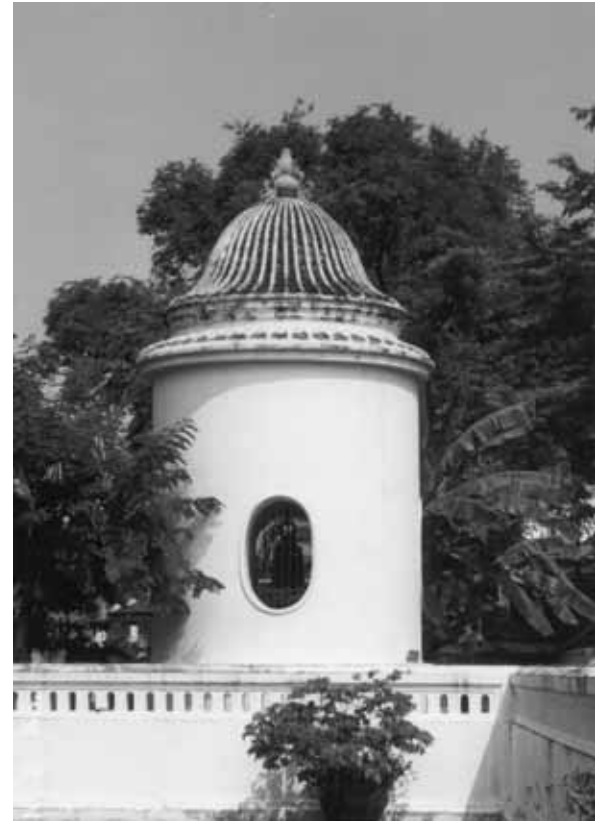
หอรระฆัง วัดโสมนัสวิหาร สร้างเป็นอาคารก่ออิฐถือปูนหลังคาทรงเกี้ยว
