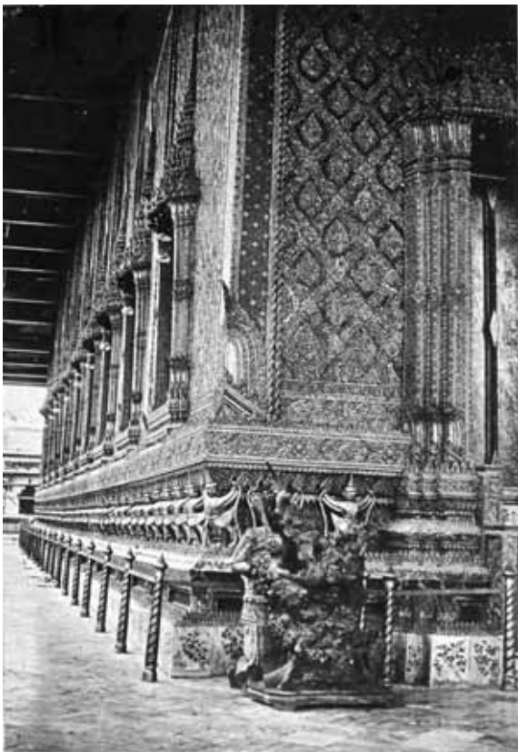
ฐานพระอุโบสถวัดพระศรีรัตนศาสดาราม ทำเป็นฐานทำสิงห์ ทรงเครื่อง ท้องไม้รองฐานไขส่วนให้สูงขึ้น ประดับภาพครุฑ จับนาครายโดยรอบ ในภาพ เป็นระเบียงด้านใต้
