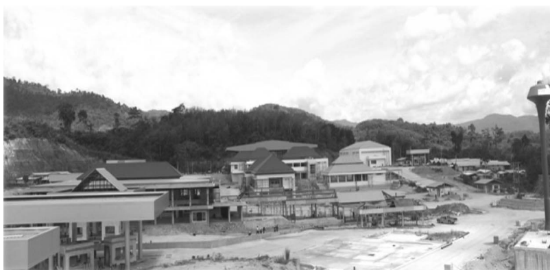
ความคืบหน้าการก่อสร้างด่านศุลกากรบ้านประกอบ (ภาพวันที่ 23 พฤษภาคม 2555)
