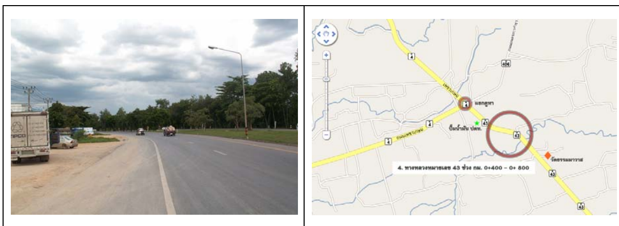
รูปที่ 2.7 จุดอันตรายลำดับที่ 4 ทางหลวงหมายเลข 43 กม. 0+400– 0+850
