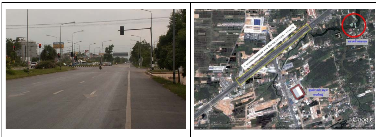
รูปที่ 2.4 จุดอันตรายลำดับที่ 1 ทางหลวงหมายเลข 414 กม.17+125 – 17+975
