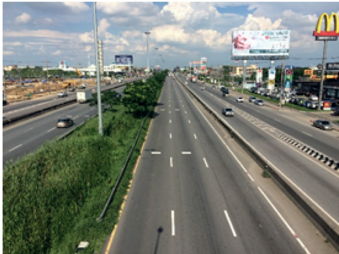
รูปที่ 2 Transverse Bar ที่ติดตั้งบนทางหลวงแผ่นดินหมายเลข 35 สายธนบุรี-ปากท่อ หรือถนนพระรามที่ 2
