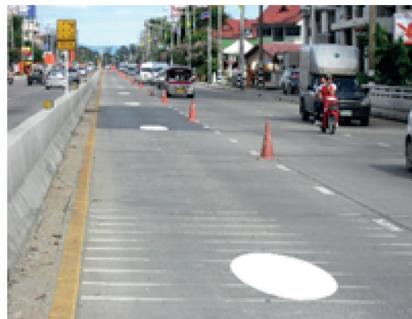
รูปที่ 5 การติดตั้งเครื่องหมายบนผิวจราจรแบบ “Dot” บนทางหลวงหมายเลข 1141
