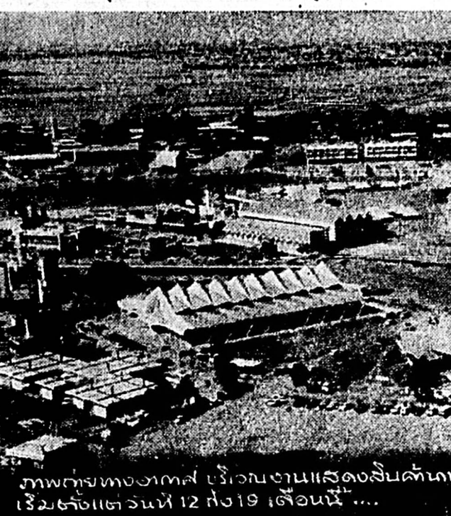
ภาพถ่ายของงานก่อสร้างและสิ่งปลูกสร้างขนาดใหญ่ ซึ่งงานเริ่มสร้างเมื่อวันที่ 12 ถึง 19 เดือนนี้...
