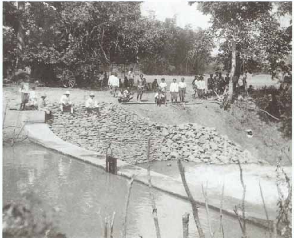
๑๑ - 11 ทำนบกั้นน้ำคลองลำน้ำปาว จังหวัดนครราชสีมา Irrigation dam on the Lamnampru Canal, Nakhon Ratchasima.
