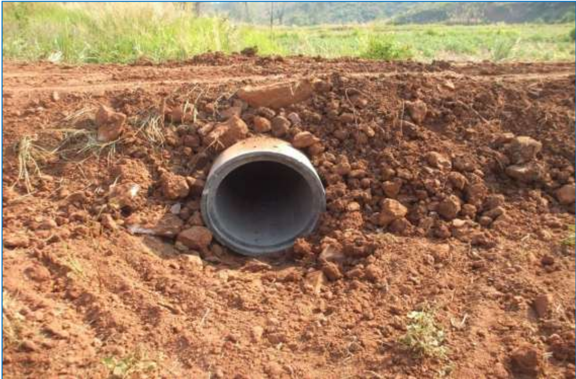
ภาพภาคผนวกที่ 7 ท่อระบายน้ำแฉวเดียวในเขตพัฒนาที่ดินลุ่มน้ำคลองน้ำเพี้ย
