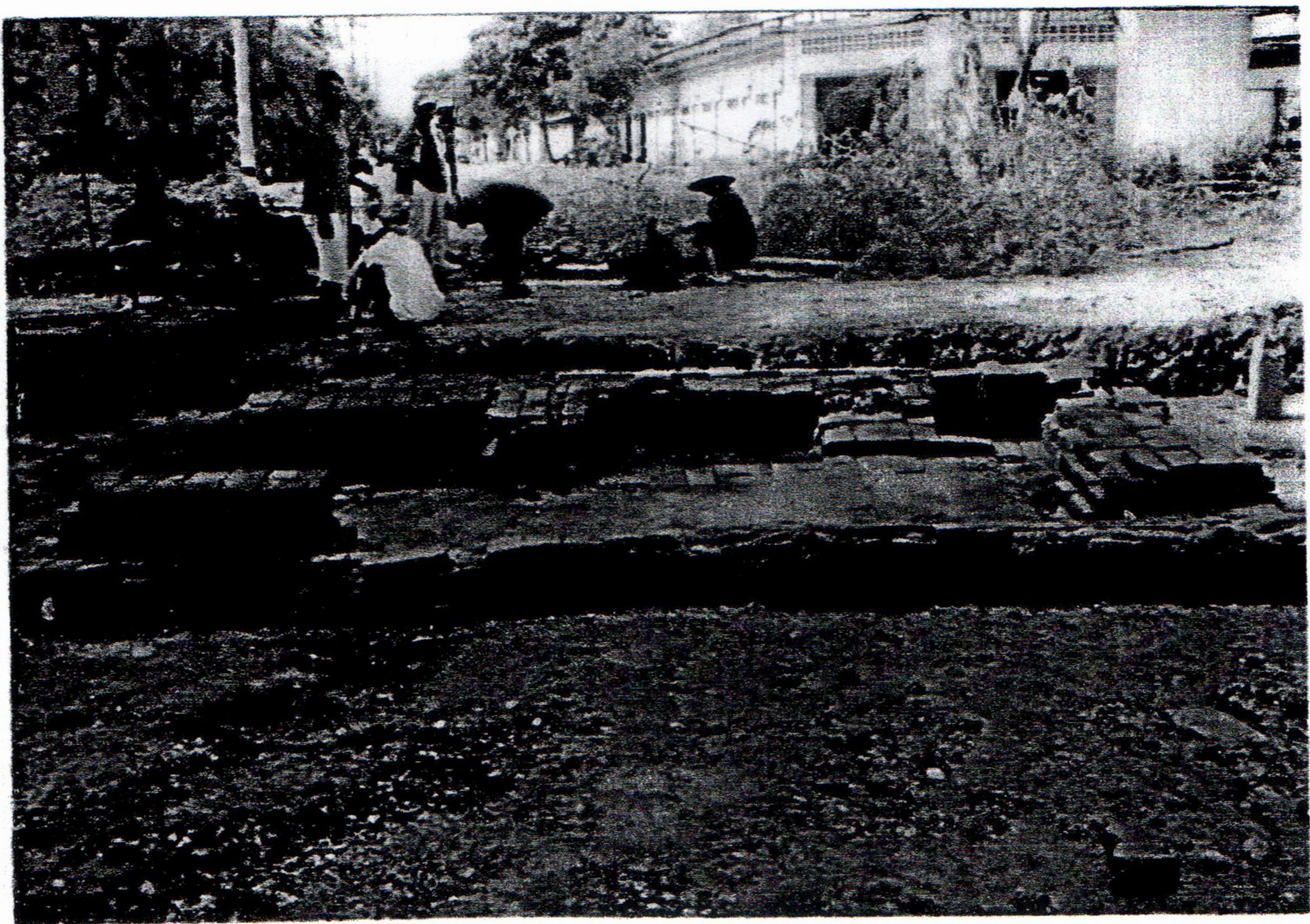
14 กำแพงเมืองด้านทิศเหนือ จะเห็นลักษณะการก่ออิฐเกือบเต็มแนวกำแพง โดยเว้นเป็นช่องสี่เหลี่ยมแล้วถมดินภายในเรียงรายไปตามแนวกำแพง
