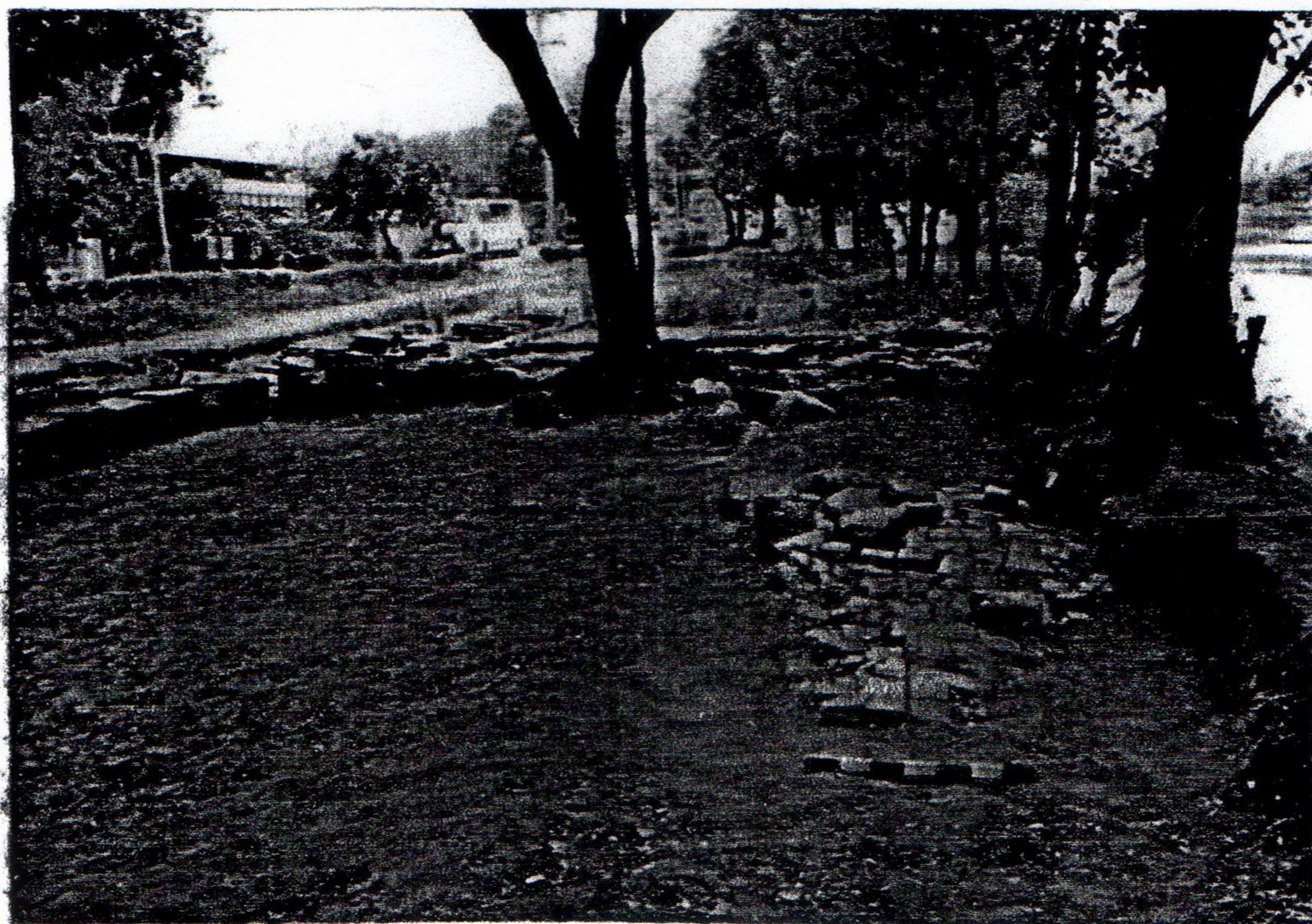
38 ผนังป้อมด้านทิศเหนือและทิศตะวันตก
