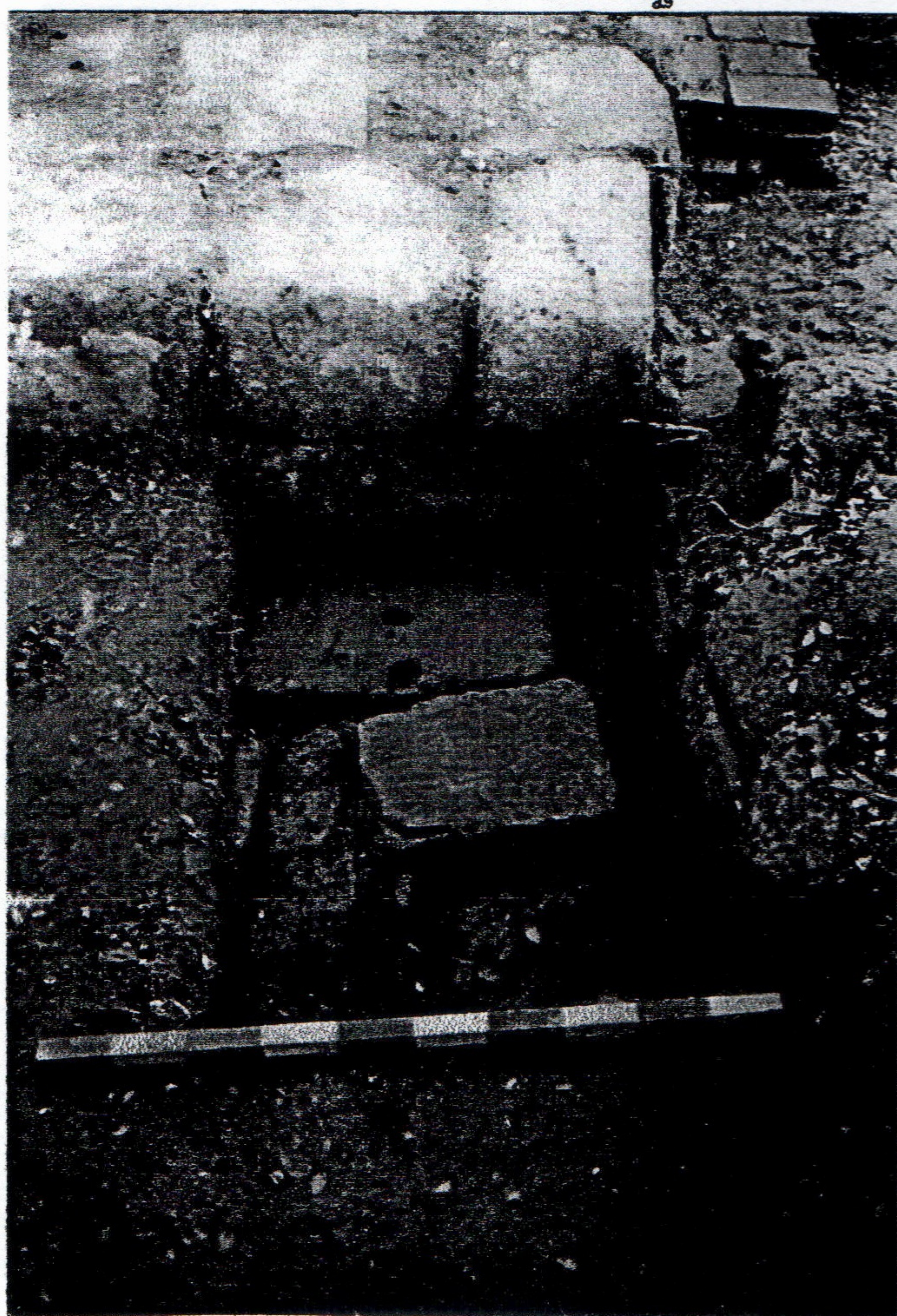
28 แนวก้อนหินทรายที่ก่อเป็นขอบนอกที่เป็นช่วงต่อ ระหว่างผนังป้อมกับกำแพงเมืองด้านทิศเหนือ
