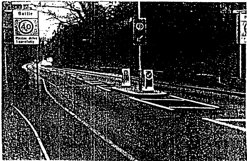
ประตูลดความเร็ว : ลดความกว้างของถนนและช่องจราจรเพื่อบีบให้รถลดความเร็ว จาก Ogden (1969) หน้า 353.
