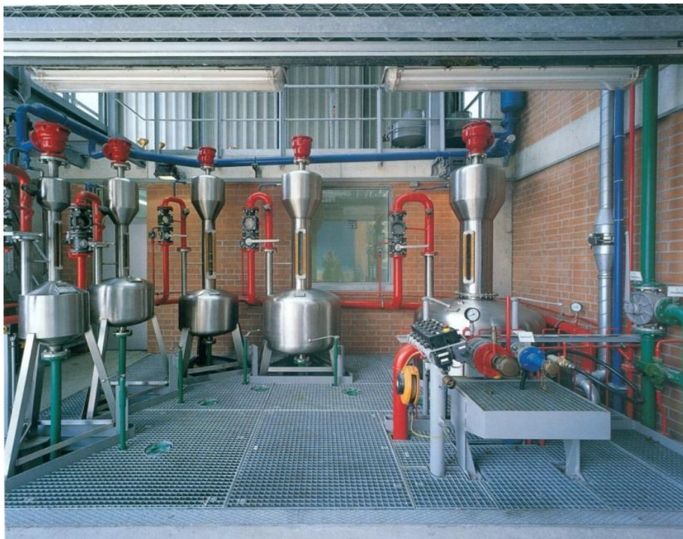
รูปที่ 6-20 ติดตั้งอุปกรณ์ระบายความดัน (Pressure Relief Valve) หรือ Vacuum Breaker (Eichamt Nurnberg, Germany)
