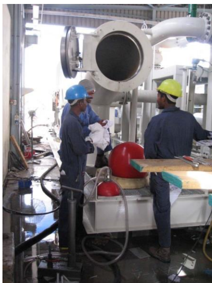
รูปที่ 9-44 ลูกบอลใน Conventional pipe prover ที่ไปดัน Detector และแบ่งของเหลว
