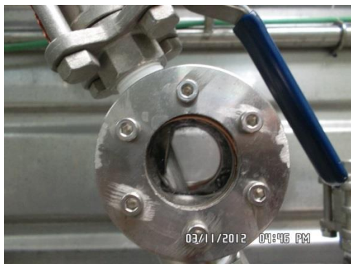
รูปที่ 9-25 ตัวอย่าง Sight glass ด้านทางออกถังตวงแบบมาตรา
