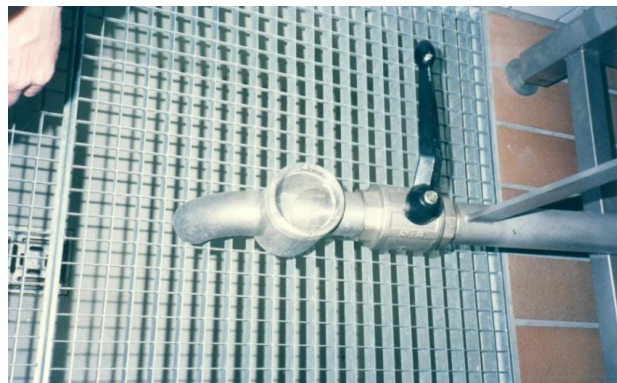
รูปที่ 9-25 ตัวอย่าง Sight glass ด้านทางออกถังตวงแบบมาตรา
