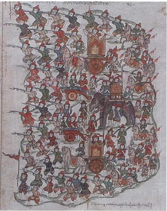
ให้เคลื่อนทัพเข้าตีด้วยขบวนวารีเวคะพยุหะ ให้เคลื่อนทัพเข้าตีด้วยขบวนที่จะระพยุหะ
