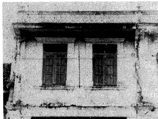
รูปด้านชั้นบน สมาคมสหมิตร ภูเก็ต
