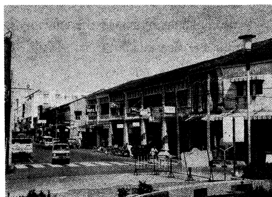
อาคารห้วมถนนรัชฎาฝั่งเลขคู่ มองจากวงเวียน
