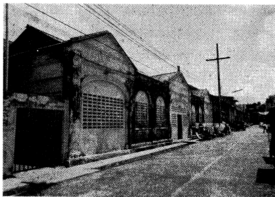
อาคารฝั่งด้านหลังโรงเรียนภูเก็ตไทยหัว
