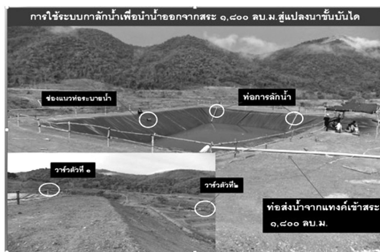
รับน้ำไว้ที่สระเก็บน้ำ ก่อนจะส่งน้ำไปที่แปลงนา
