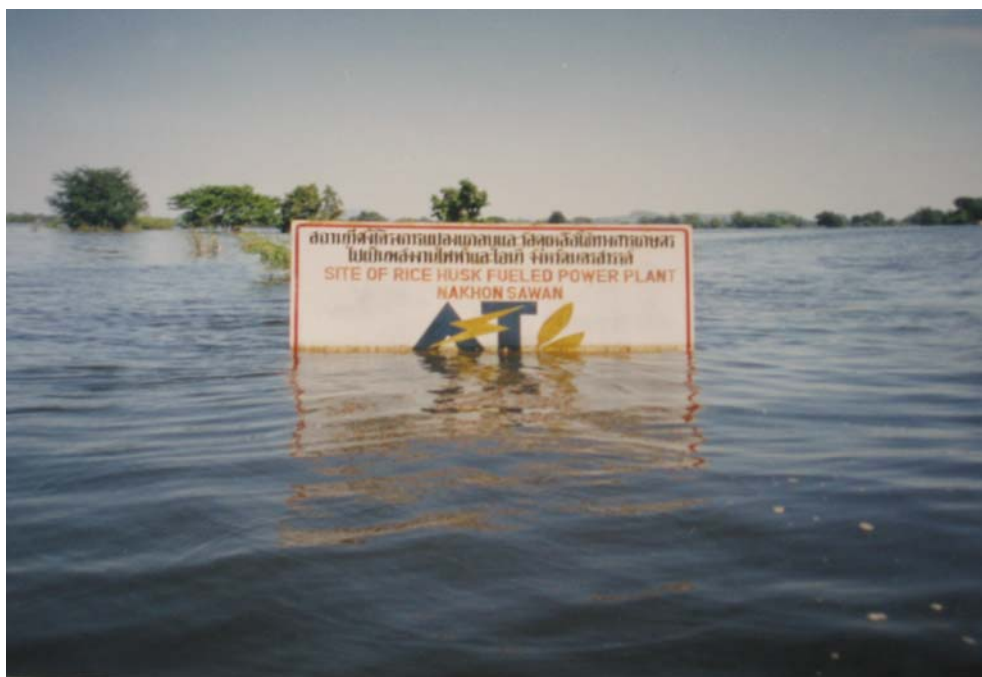
ภาพที่ 7 สภาพน้ำท่วมน้ำหลากบริเวณพื้นที่โครงการที่จังหวัดนครสวรรค์ช่วงเดือนตุลาคม 2545 ระดับน้ำสูงประมาณ 2.8 เมตร
