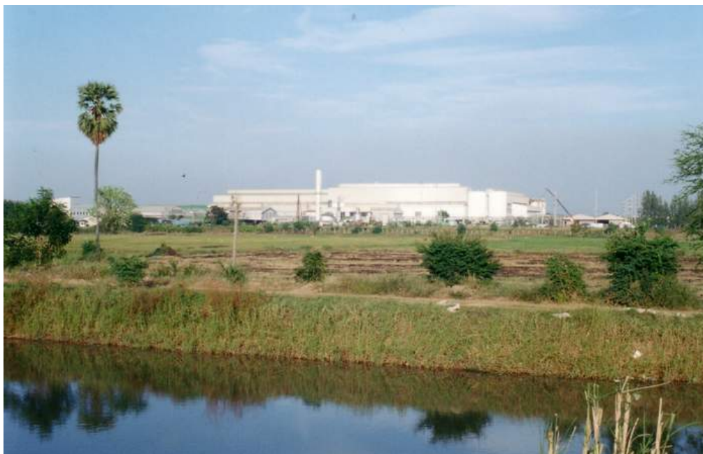
ภาพที่ 1 พื้นที่ก่อสร้างโครงการโรงไฟฟ้าแกเลบที่ตำบลโพกรรม จังหวัดสิงห์บุรี อยู่ใกล้กับโรงงานกระดาษ
