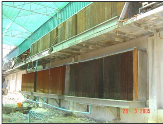
การปรับอุณหภูมิความร้อนโดยการติดตั้ง cooling pack ในแผนกผลิตปุ๋ยเทียม
