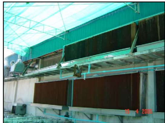
การปรับอุณหภูมิความร้อนโดยการติดตั้ง cooling pack ในแผนกผลิตปุ๋ยเทียม
