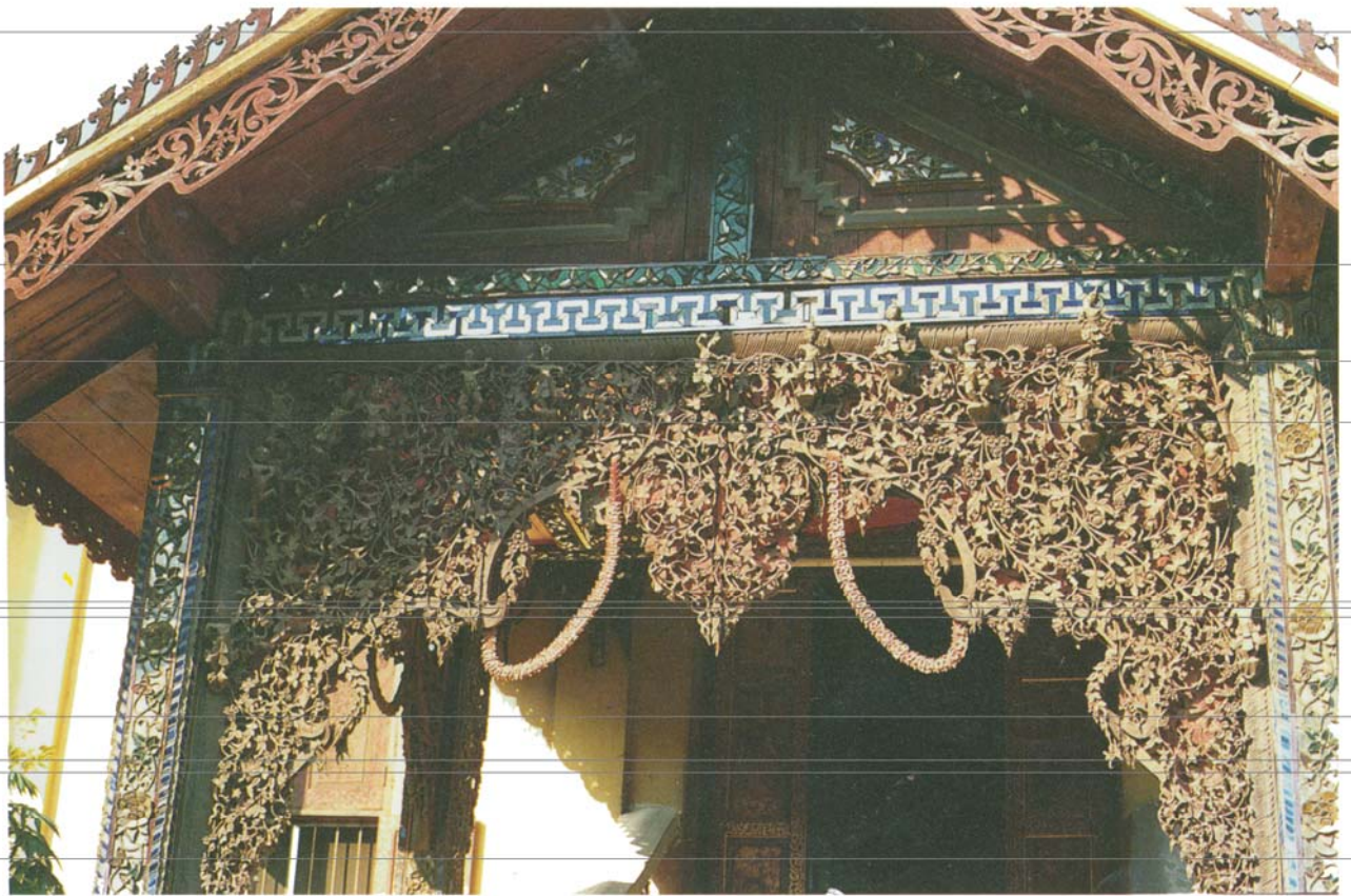
๕.๔ (บน) รายละเอียดการซ้อนชั้นหลังคาเรือนยอดวิหาร
