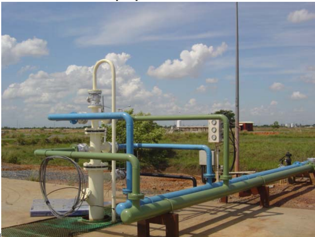
ภาพที่ 8 - 9 โรงสูบน้ำมูลเพื่อใช้ละลายหินเกลือของเหมืองเกลือพิ
