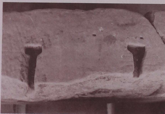
ภาพที่ ๓ ทับหลังที่เจาะสักรัดให้เป็นเบ้าเพื่อใส่เหล็กตัวปลิง
