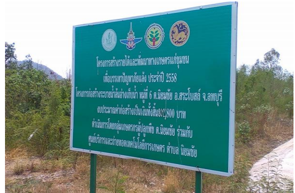
ภาพที่ 10 โครงการก่อสร้างฝายน้ำล้น ต.นิคมชัย อ.สระโบสถ์ จ.ลพบุรี
