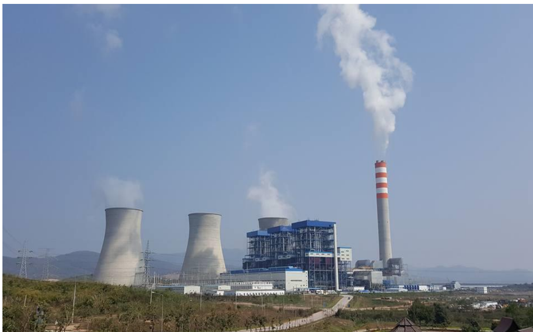
ภาพที่ 1 โรงไฟฟ้าพลังงานความร้อนหงสา
