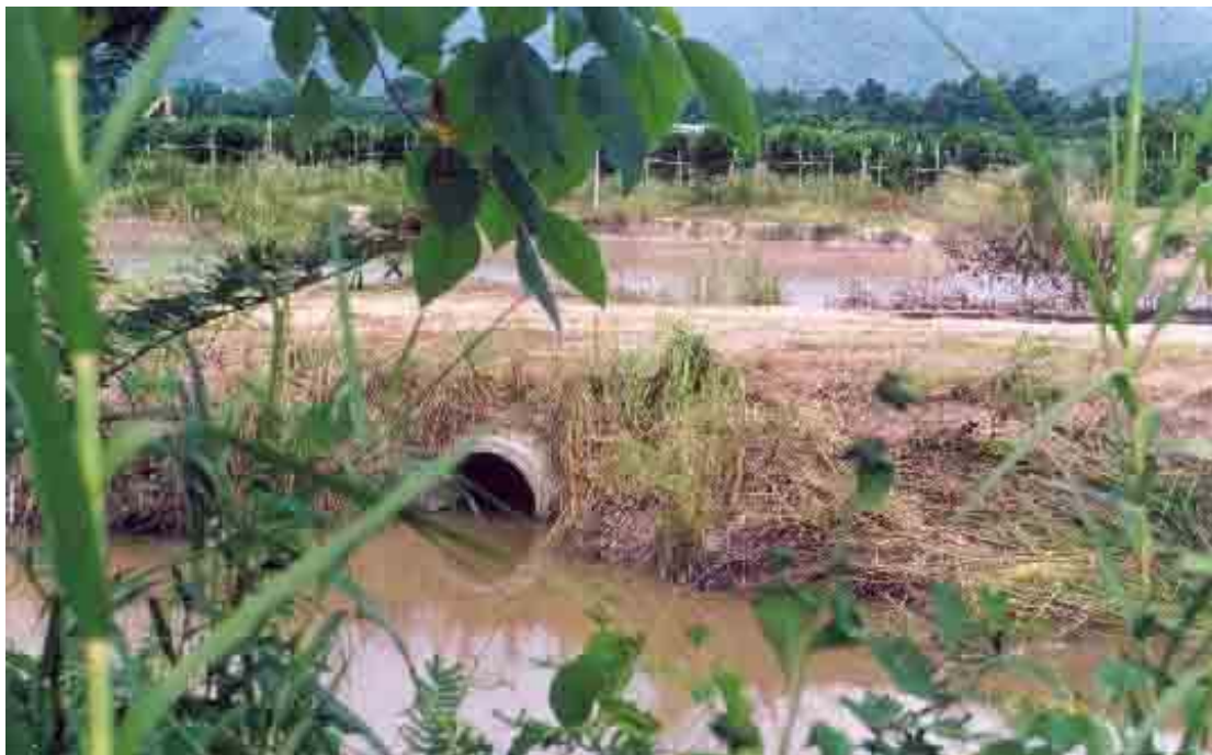
รูปที่ 5-4 การขุดบ่อักเก็บน้ำต้นลำเหมืองเพื่อนำน้ำเข้าสวนส้ม
