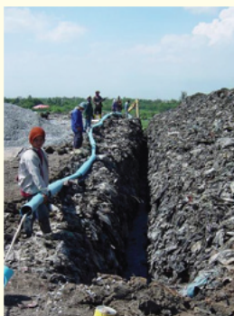
รูปแสดงการวางท่อรวมก๊าซชีวภาพและระบบฝังกลบเพื่อผลิตก๊าซชีวภาพ
