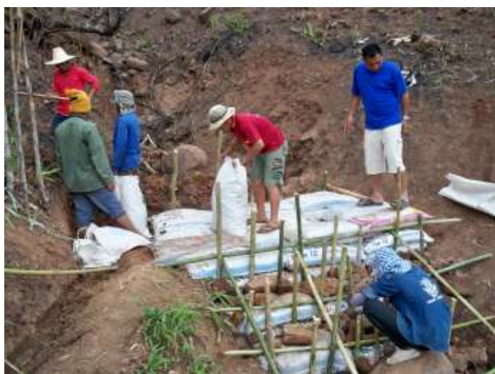
ภาพที่ 13 ก่อสร้างอาคารชะลอน้ำ
