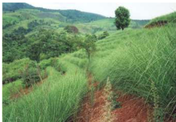
ภาพที่ 15 ปลูกรั้วหญ้าแฝกไหล่ทาง
