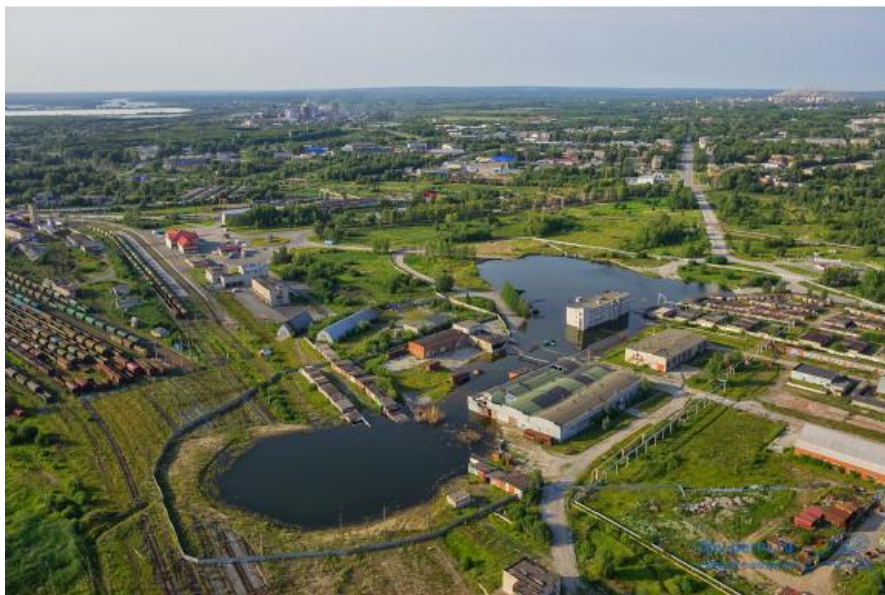
รูปที่ 6.6.8 หลุมยุบที่ 2 และ 3 รวมตัวกัน อาคารหลังคาสีแดงคือสถานีรถไฟปรีชนิก (ที่มา fpv.perm.ru)
