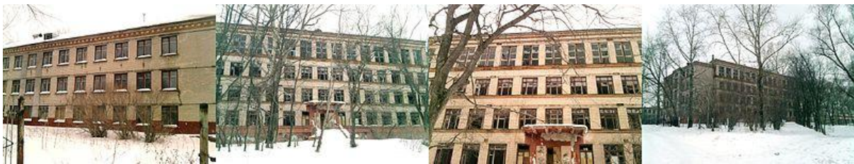
รูปที่ 6.6.11 สภาพอาคารโรงเรียนนานาชาติที่ถูกทิ้งร้างเนื่องจากการเคลื่อนย้ายคนออกไปเพราะอยู่ในพื้นที่ภัยพิบัติมองเห็นอาคารแตกร้างอยู่ทั่วไป (ที่มา: ru.wikipedia.org)
