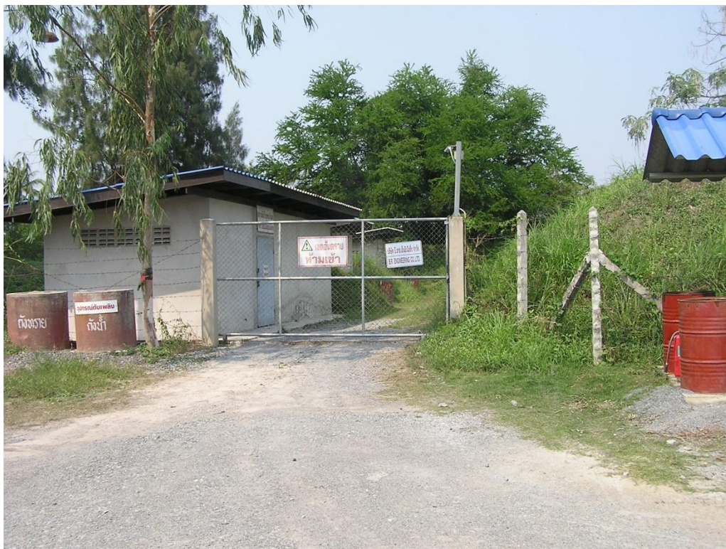
รูปที่ 6.9.1 คลังเก็บวัตถุระเบิดที่ไม่ทำคันดินด้านที่หันหน้าเข้าหาสำนักงาน
