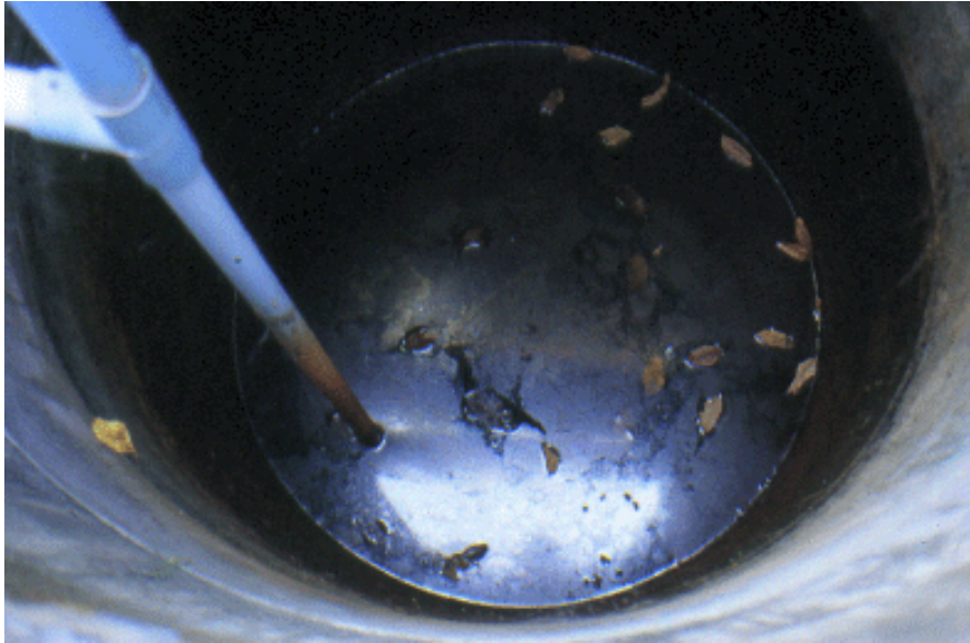
รูปที่ 4.6 สภาพบ่อน้ำดินแห่งหนึ่งในชุมชนมabay น้ำมีลักษณะเป็นตะกอนคล้ายสนิม ไม่สามารถใช้ได้ (ถ่ายเมื่อวันที่ 26 พฤศจิกายน 2544)
