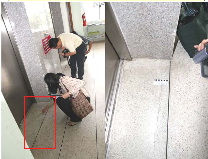
รอยแตกร้าวของคอนกรีตบริเวณพื้นหน้าลิฟต์ชั้น 2 ขนาด 0.8 มม.
