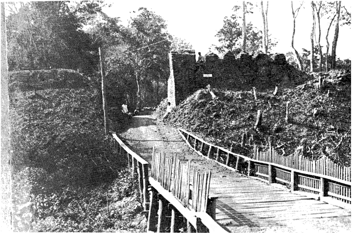
ประตูเมืองกำแพงเพชร ด้านทิศตะวันออกเฉียงเหนือ ที่ขอประตูโคม พระบาทสมเด็จพระมงกุฎเกล้าเจ้าอยู่หัวทรงถ่ายไว้คราวเสด็จประพาส เมืองกำแพงเพชร เมื่อ พ.ศ. ๒๔๖๕
