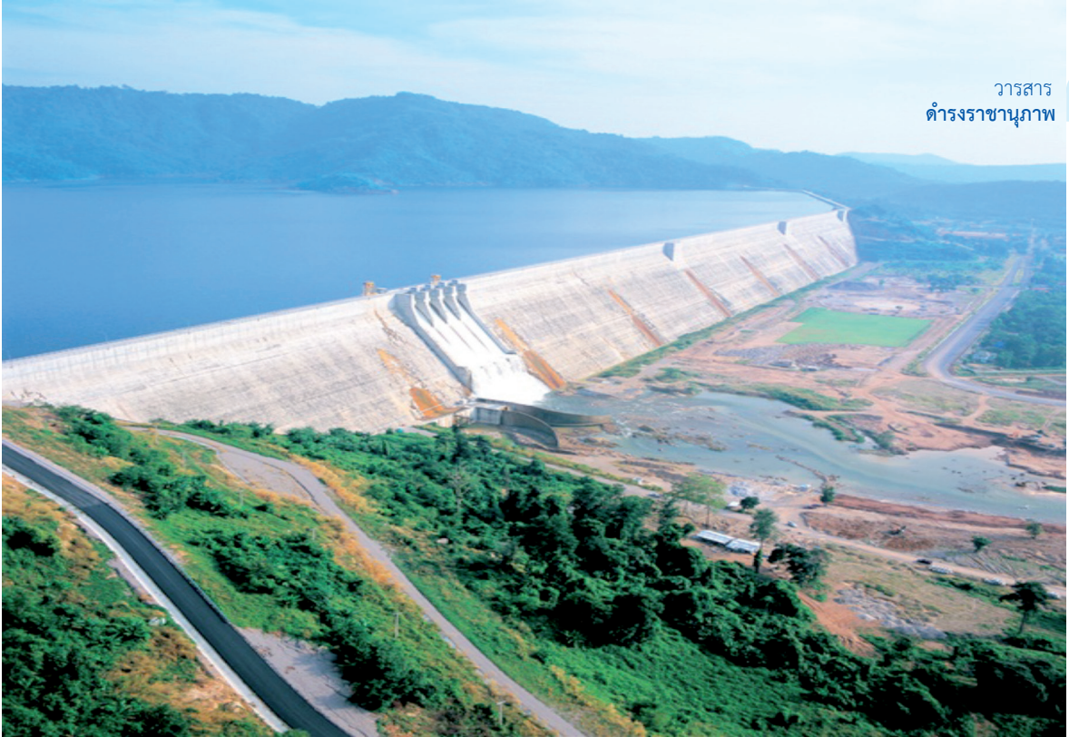
เขื่อนขุนด่านปราการชล จังหวัดนครนายก สูง 95 เมตร...เขื่อนคอนกรีตบดอัดแน่น
