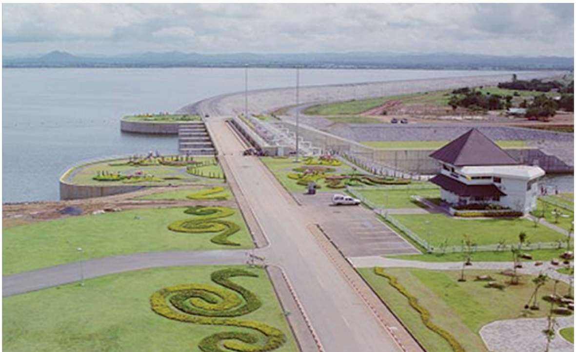
เขื่อนปากชลสิทธิ์ จังหวัดลพบุรี เขื่อนดินถมบดอัดแน่นขนาดใหญ่ ความจุอ่างเก็บน้ำ 960 ล้านลูกบาศก์เมตร
