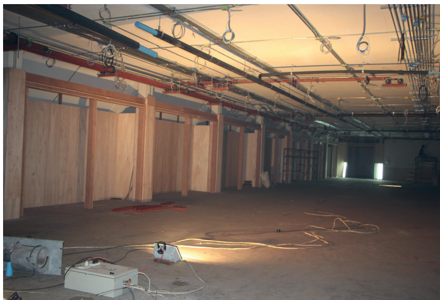
การรื้อฝ้าผนังเพื่อทำการติดตั้งวางระบบดับเพลิงอัตโนมัติ ซึ่งเป็นระบบที่มีความสำคัญมากในการวางระบบโครงสร้างการปรับปรุงอาคารห้องสมุด
