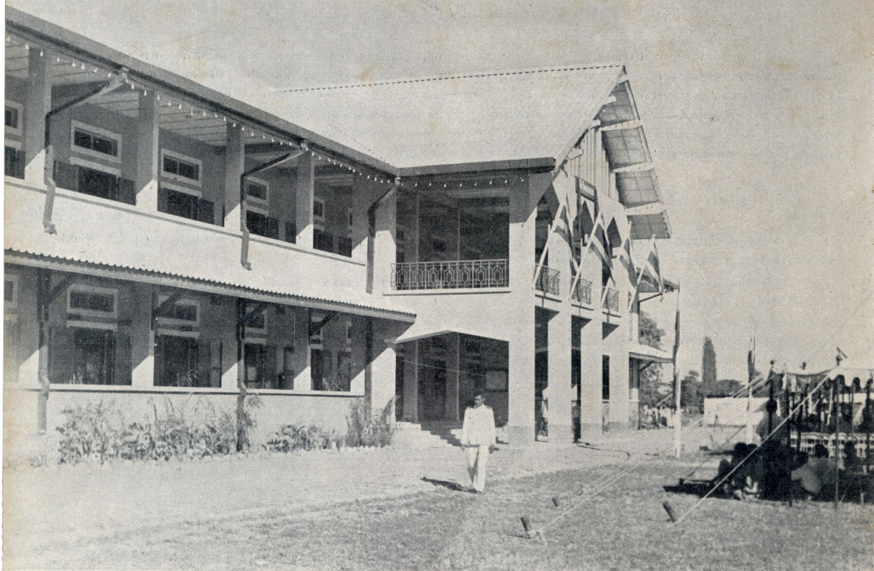
ตึกวิทยาศาสตร์ของกรมมหาวิทยาลัยเกษตรศาสตร์ เป็นตึกคอนกรีตเสริมเหล็ก ๒ ชั้น กว้าง ๑๑ เมตร ยาว ๖๒ เมตร มีมุขหน้าและเฉลียงกว้าง ๓ เมตร ขาดตลอดตัวตึก ค่าก่อสร้าง ๑,๓๕๐,๐๐๐ บาท
